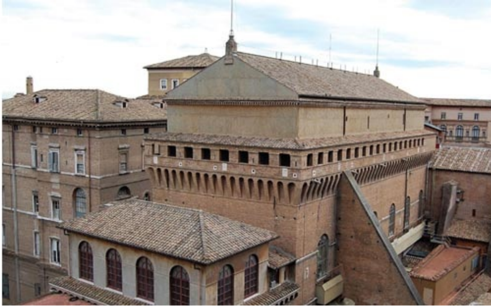
Fotografía 1. Vista de la capilla Sixtina desde el tejado de la catedral de San Pedro. Fotografía de Roy Doliner.
